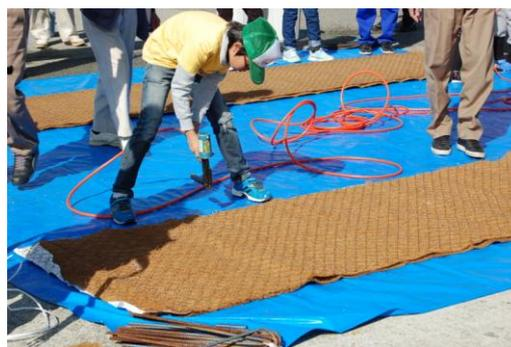
写真-4.16 菱形金網を被せ、一体化
