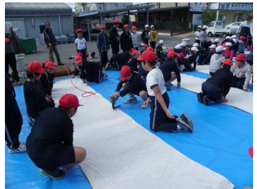
ヤシマットの上にレーヨンを重ね、ホックリング・ガンで仮留め
