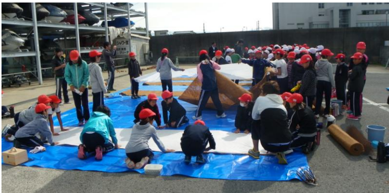
ヤシマットの上にレーヨンを重ね、ホックリング・ガンで仮留め
